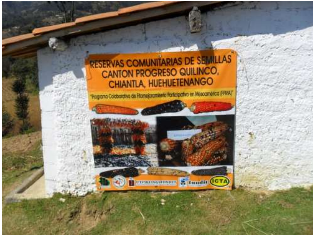
Fotografía 1: RCS Quilenco. Vista Lateral, paredes de Adobe y techo de teja.
