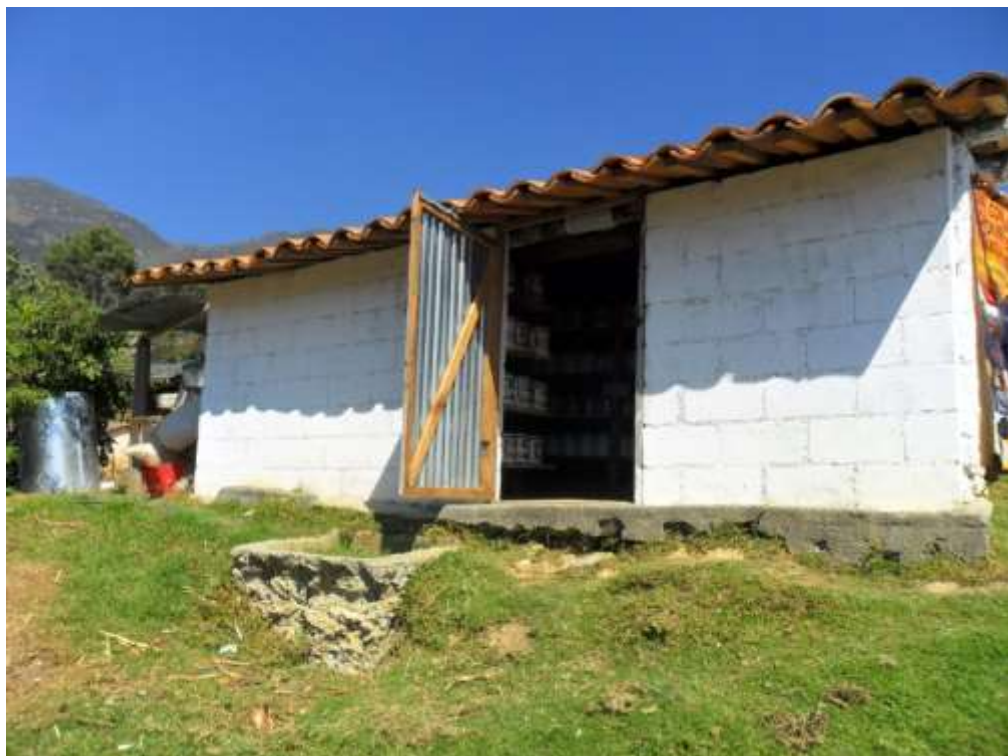
Fotografía 2: RCS Quilenco. Vista Frontal, paredes de block y puerta de lámina
